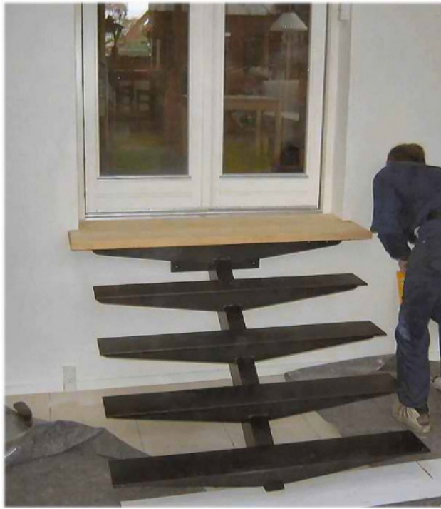
Fig.3 Montering af indendørs centertrappe
