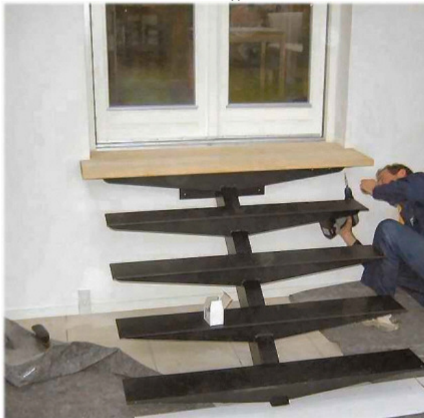
Fig.4 Montering af indendørs opsadlet centertrappe.
