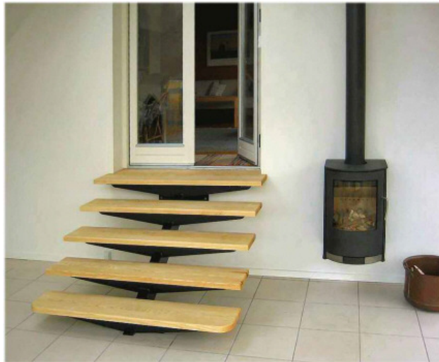
Fig.5 Centertrappe, Montering indendørs.
