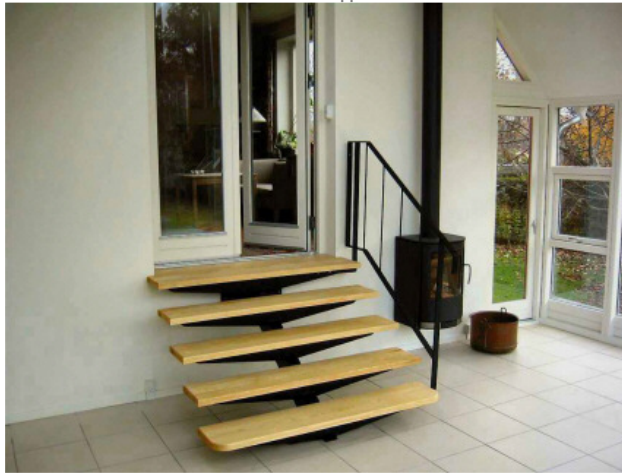
Fig.1 Opsadlet trappe med trappetrin af asketræ.
